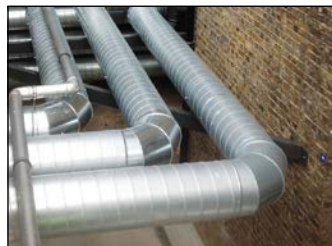
Крепление трубопроводов, воздухопроводов, электрики
