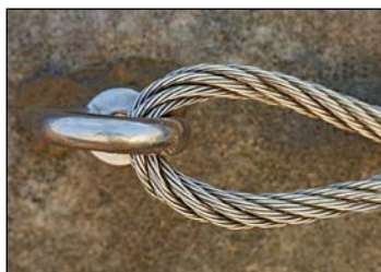
Монтаж такелажных систем
