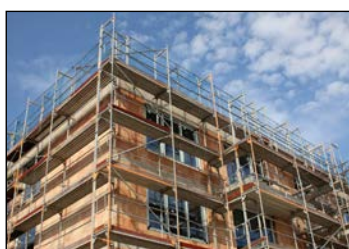
Монтаж строительных лесов
