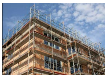
Монтаж строительных лесов
