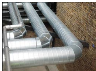
Крепление трубопроводов, воздухопроводов, электрики
