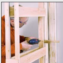
Крепление направляющих для лёгких конструкций
