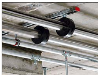
Крепление инженерных сетей
