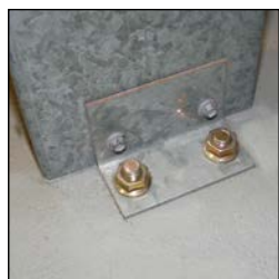
Крепление самонесущих конструкций
