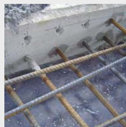
Устройство анкерных выпусков, при реконструкции, усилении конструкций, ошибках проектировании.
